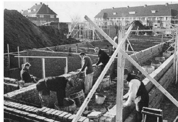
Bouw van de Hoeksteen (1950-1951)
